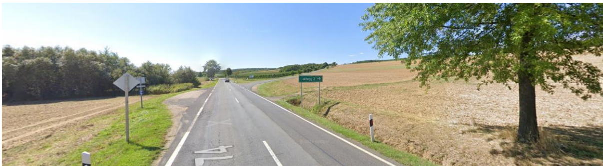
74107 j. bekötő út külterületi szakasza a 74 sz. főút csatlakozásánál (ggogle maps 2021)
